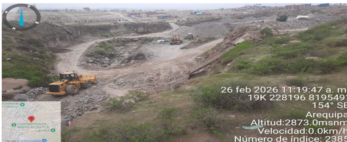
IMAGEN 02: SE MUESTRA EL CAUCE DE LA QUEBRADA OBSTRUIDO POR MATERIAL DE ACARREO SE OBSERVAN LAS MAQUINARIAS TRABAJANDO AGUAS ARRIBA
