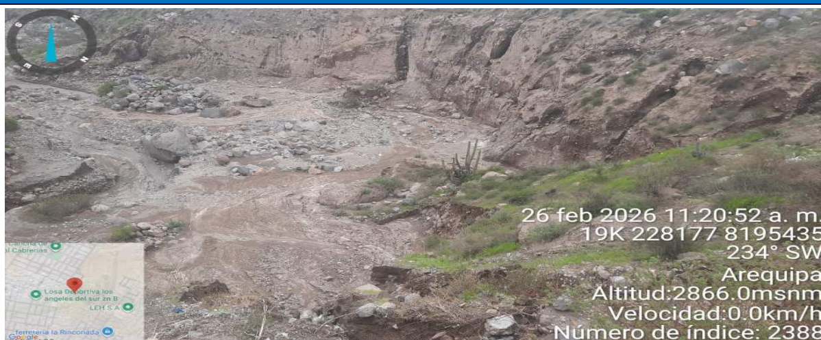
IMAGEN 01: SE MUESTRA LA COLMATACION Y LA EROSION DE LA QUEBRADA GAMARRA DONDE SE PROPONE CONSTRUIR 01 DIQUE TRANSVERSAL PARA MITIGAR LA EROSION Y HUAYCOS AGUAS ABAJO EN EL SECTOR CABRERIA
